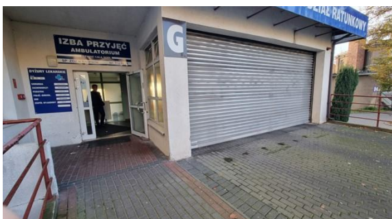
Zdjęcie nr 8: Wejście SOR.
