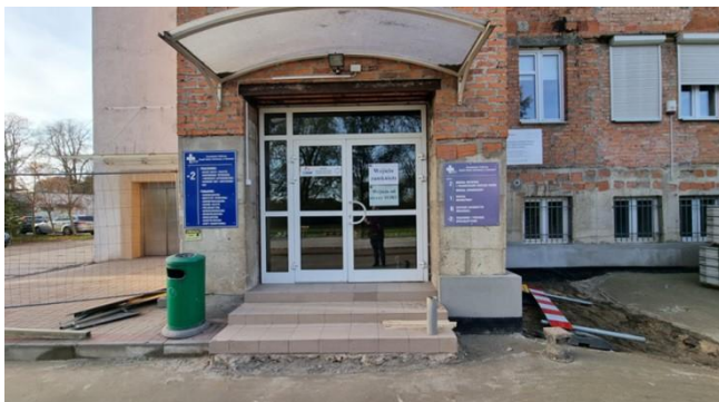
Zdjęcie nr 7: wejście główne do budynku.
